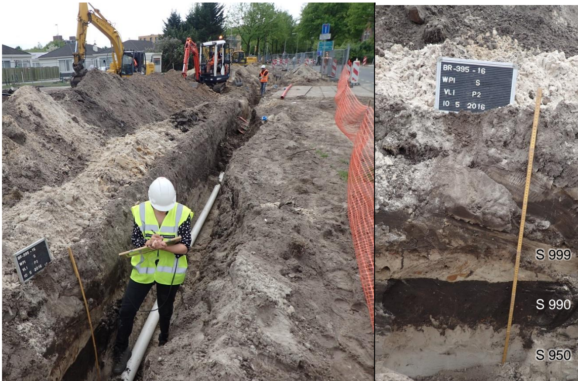
Afbeelding 5. Documentatie van het bodemprofiel tijdens werkzaamheden aan de Verlengde Poolseweg, met rechts profiel 2.
